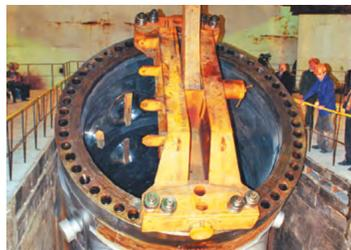
16 декабря 1997 года – установка корпуса реактора энергоблока № 3 на штатное место
